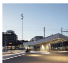
Winterthur ZH: Gleisquerung Stadtmitte
