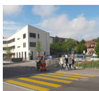
Niederlenz AG: Sanierung Hauptstrasse
